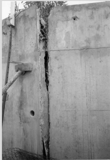
*Exemple de destabilisation d'un mur en raison d'un mauvais drainage. Lors de fortes précipitations, une forte pression s'accumule derrière le mur et exerce sur lui une force horizontale.*
